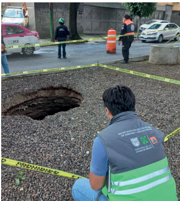
Imagen 03 | Visita Técnica por presencia de socavón en vialidad primaria de la alcaldía Miguel Hidalgo, en la Ciudad de México, SGIRPC.
