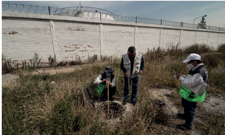
Imagen 18 | Visita técnica para la elaboración de reporte por detección de hidrocarburos en un predio de la Ciudad de México.
