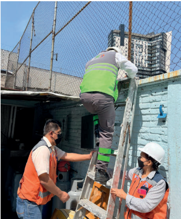
Imagen 06 | Revisión de las instalaciones de gas, como parte de las actividades del Programa Alimento Caliente.
