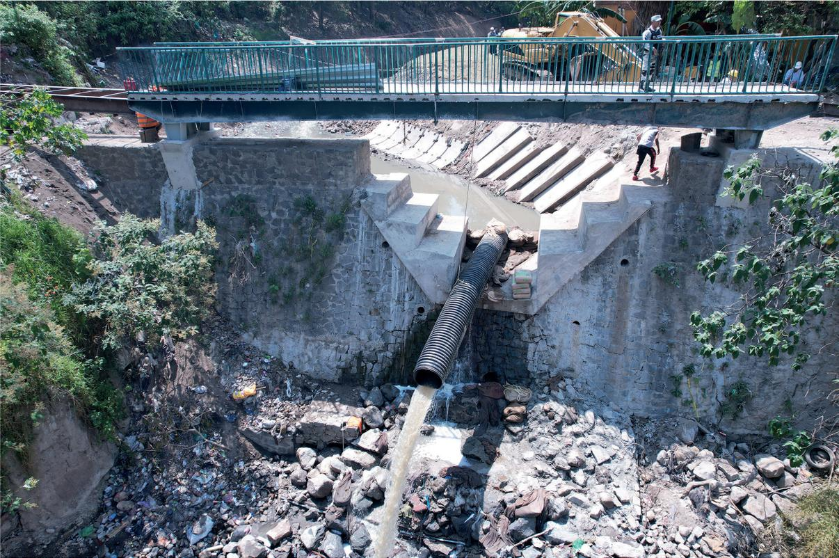
Imagen 12. Modificaciones al muro vertedero existente para facilitar el flujo del agua
