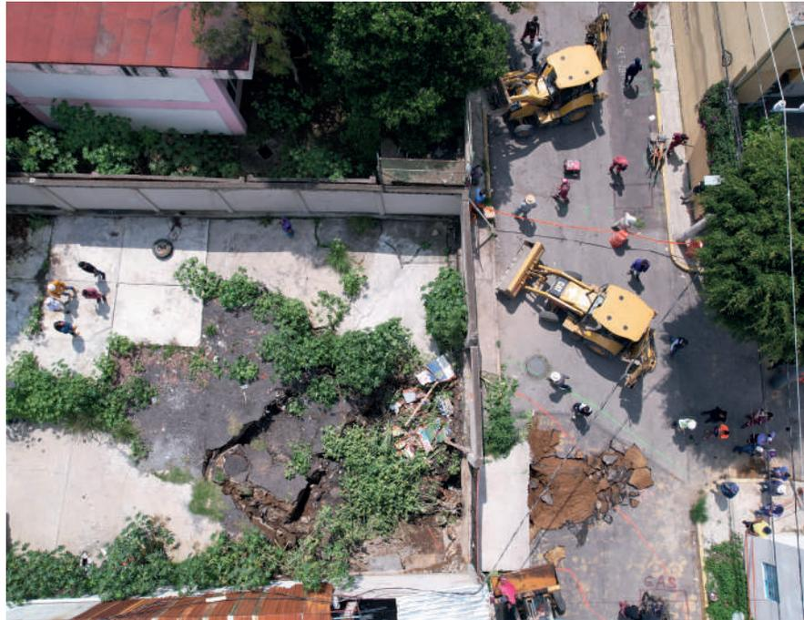
Imagen 4. Levantamiento de vuelo de dron por socavón en Lomas de Tezonco de la alcaldía Iztapalapa, SGIRPC
